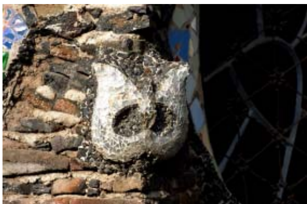
Calç aèria additivada formant el marc d'algunes finestres i els relleus decoratius.
