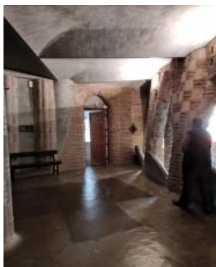
Lliscat de morter de ciment en el cor de l'església, que abasta la totalitat de la nau, l'arrambador i revesteix parcialment algunes de les columnes.
