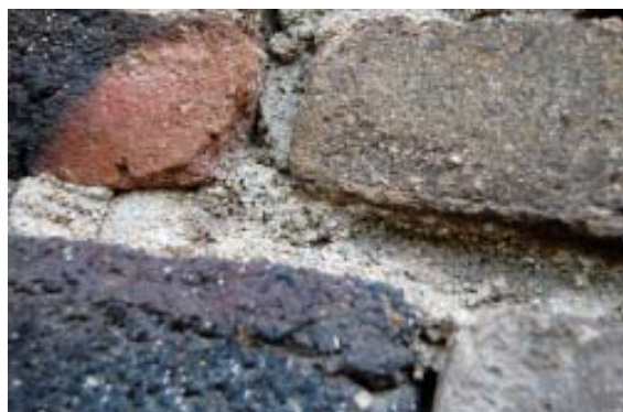
Junta de morter de ciment pòrtland de la fàbrica de totxo i escòria dels paraments exteriors.
