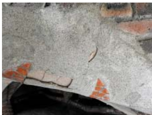
Base de ciment ràpid que forma els volums de la decoració dels arcs.
