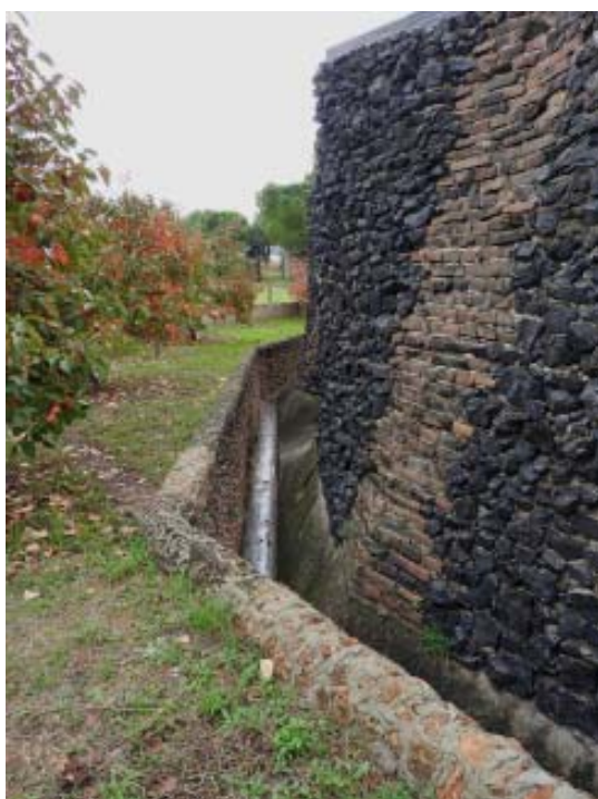
Canal de desguàs al perímetre nord de l'església.
